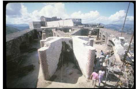
• Restauration de la Batterie Coidavid de la Citadelle Henry
