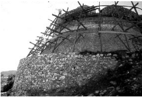
• Restauration du fort Jacques à Fermathe (1979)
